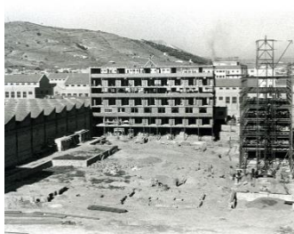
Aquesta imatge mostra la construcció per blocs i l'estructura metàl·lica que s'utilitzà (1934).
