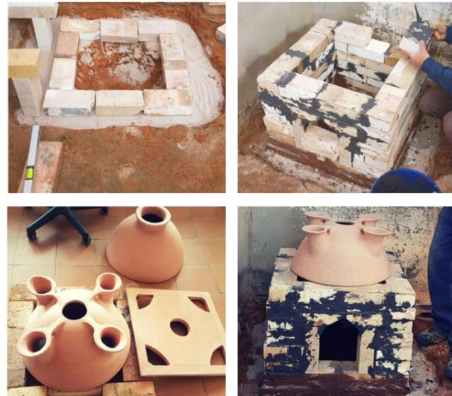
Fig.3. Preparación de la cámara de combustión.
