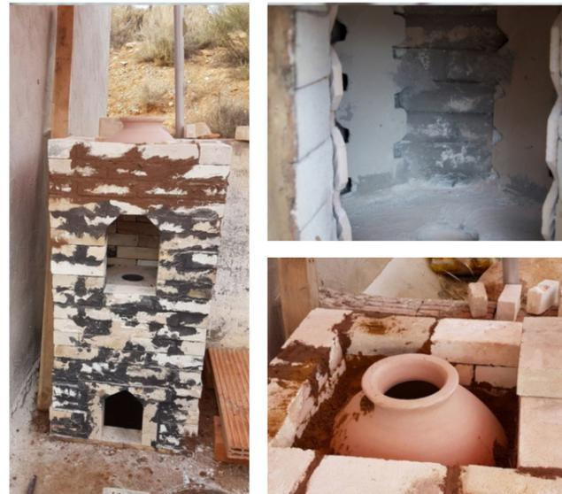
Fig.4. Preparación de la cámara de cocción.
