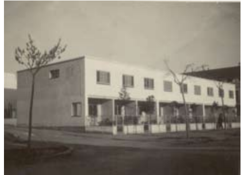
El Grupo de viviendas obreras tras ser acabadas. © Cortesía de Josep Lluís Pichot
