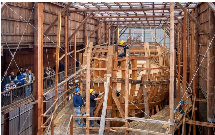
Construcció de la rèplica de la Nao San Juan
