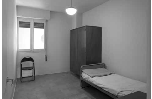
Figuras 13 y 14. La habitación individual presentaba un parquet añadido sobre el pavimento hidráulico original y varios papeles pintados. Una vez retirado todo lo sobrante, se pintó manualmente a brocha con el color azul claro que se obtuvo del análisis de las muestras cromáticas. Se amuebló con una cama alemana corriente en aquella época y que permite ver el trabajo del tubo de acero, que tanto gustaba. Se acompaña de dos piezas hechas expresamente: el armario y la mesita de noche, réplicas de las publicadas por los arquitectos en la revista AC. La silla B61 negra en acero y madera es de Thonet (1930) y procede de la vivienda barcelonesa de Germán Rodríguez Arias. © Raimon Solà, 2010. Lourdes Jansana, 2011. Museu del Disseny de Barcelona.
