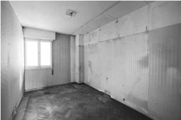
Figuras 13 y 14. La habitación individual presentaba un parquet añadido sobre el pavimento hidráulico original y varios papeles pintados. Una vez retirado todo lo sobrante, se pintó manualmente a brocha con el color azul claro que se obtuvo del análisis de las muestras cromáticas. Se amuebló con una cama alemana corriente en aquella época y que permite ver el trabajo del tubo de acero, que tanto gustaba. Se acompaña de dos piezas hechas expresamente: el armario y la mesita de noche, réplicas de las publicadas por los arquitectos en la revista AC. La silla B61 negra en acero y madera es de Thonet (1930) y procede de la vivienda barcelonesa de Germán Rodríguez Arias. © Raimon Solà, 2010. Lourdes Jansana, 2011. Museu del Disseny de Barcelona.
