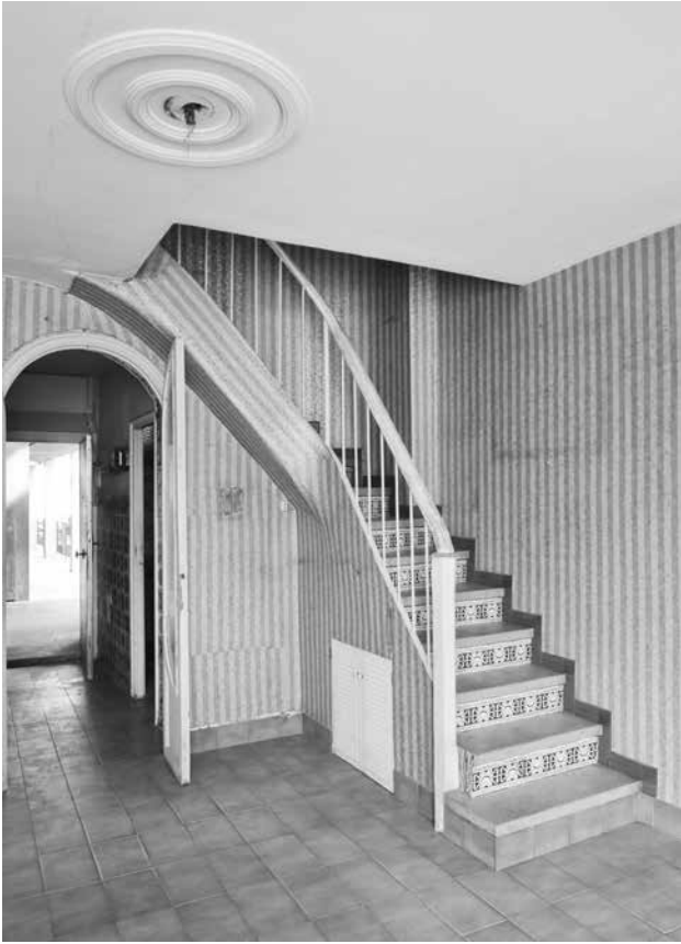
Figuras 11 y 12. Ángulo del comedor antes de la restauración, con la pared avanzada, una puerta añadida y la escalera colmada de añadidos de cariz aburguesado, que además tenía su parte baja convertida en armario. La restauración supuso derribar la pared falsa y recuperar la auténtica, liberando el espacio original. © Raimon Solà, 2010. Lourdes Jansana, 2011. Museu del Disseny de Barcelona.
