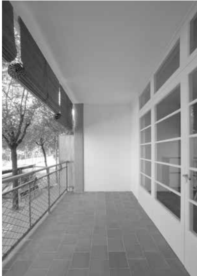
Figura 15. Se accede a la terraza, denominada así en el proyecto original, por una puerta plegable de tres batientes. Está orientada al este para aprovechar la luz solar y queda cerrada por una barandilla con malla de alambre y persianas enrollables que preservan la intimidad y regulan los rayos del sol. El pavimento está formado por baldosas de gres dispuestas al tresbolillo. A la altura de la barandilla, un panel vertical de fibrocemento resguarda la intimidad del vecino. © Lourdes Jansana, 2011. Museu del Disseny de Barcelona.
