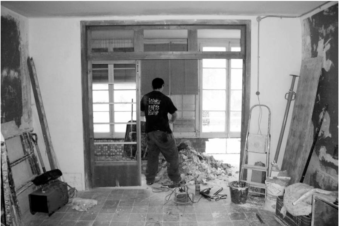
Fig. 3-4. El menjador i la terrassa abans de la intervenció i durant les obres. © DHUB. Fotografies: Raimon Solà, Rossend Casanova i Lourdes Jansana.
