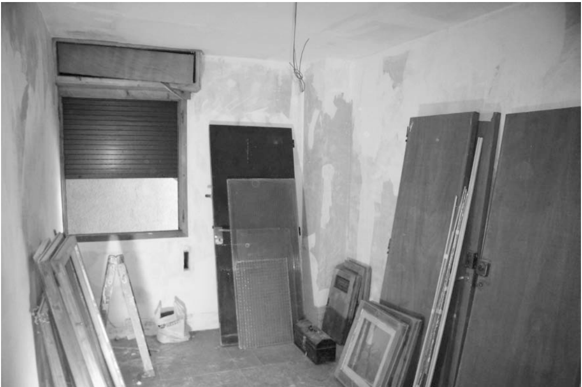
Fig. 6-7. L'habitació individual abans de la intervenció i durant les obres. © DHUB. Fotografies: Raimon Solà, Rossend Casanova i Lourdes Jansana.
