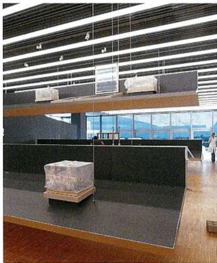
Figura 4: Proves de col·locació de marcs i vitrines i de pujada de taules per comprovar les vibracions. © Museu del Disseny de Barcelona.
